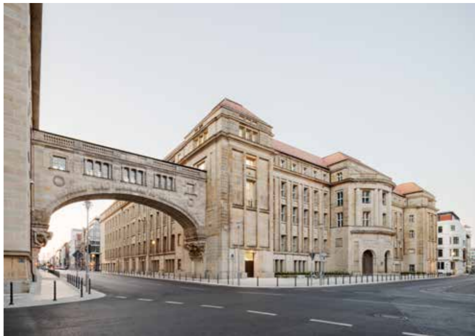
Aktuelle Aufnahme Ansicht Haus 2 (nach Fertigstellung) Current image of Block 2 (after completion)
