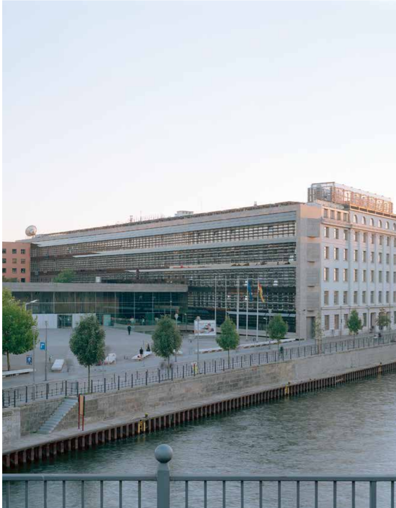
Kompakte Form, schlüssiges Gesamtkonzept: Neubau und Bestand, vom Spreeufer und aus der Luft gesehen Compact shape, coherent overall concept: new build and existing buildings, seen from the Spree riverside and from the air
