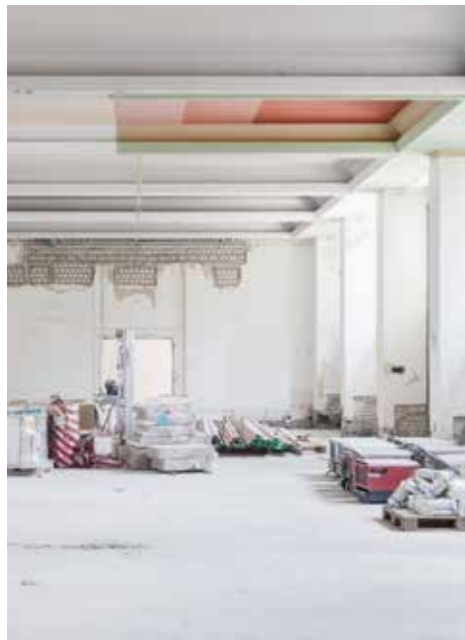
Sanierung der historischen Kassenhalle Modernization of the historical banking hall
