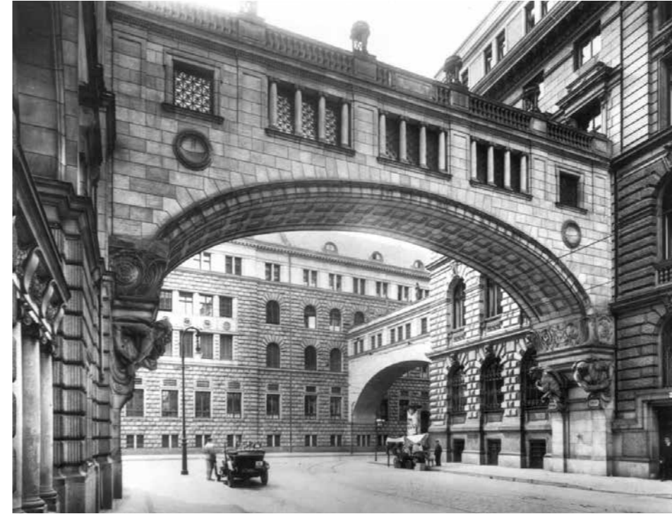
Gründerzeitliche Opulenz und historistische Ornamentik. Fassadenansichten der Deutschen Bank um 1900.
