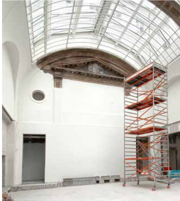
Dachkonstruktion aus Stahlträgern über der ehemaligen Kassenhalle Roof construction featuring steel girders over the former banking hall
