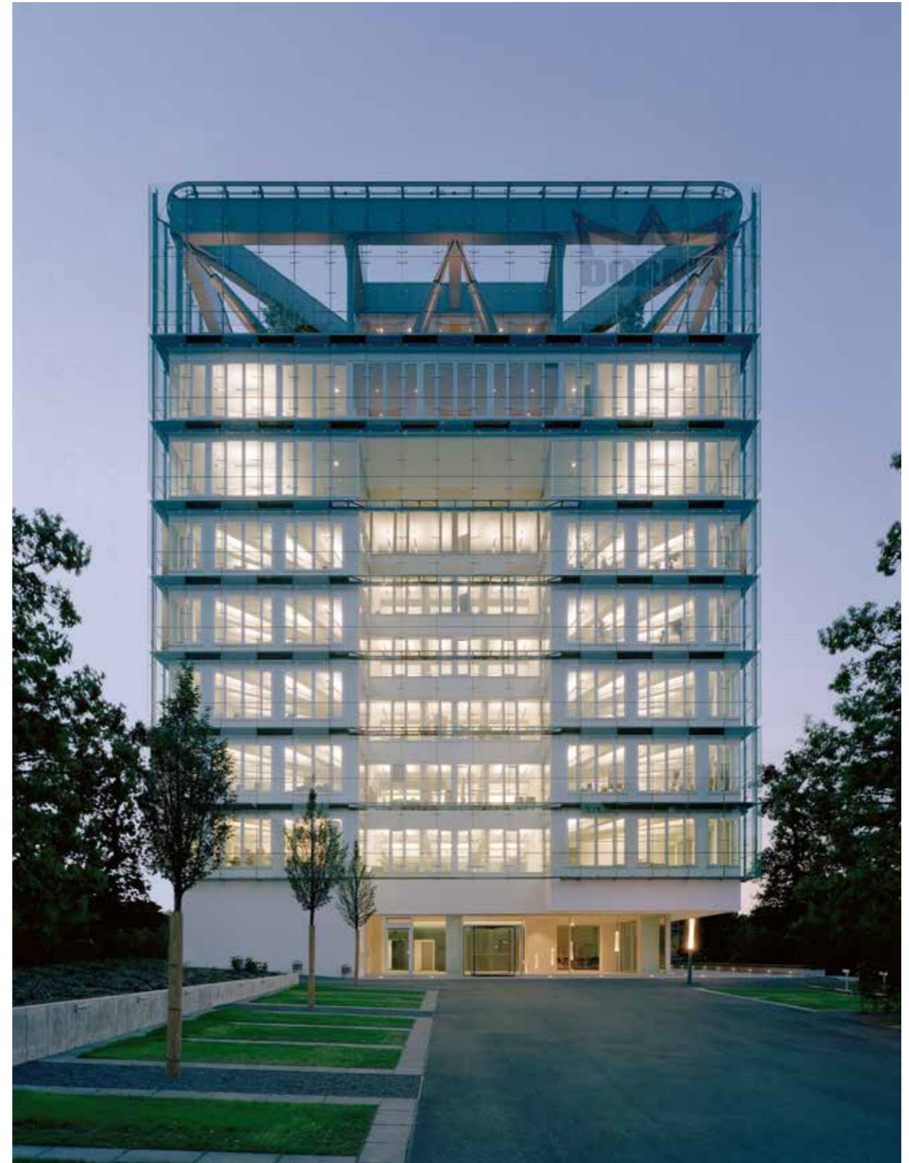
Neue Fassade rückt nach außen New facade moved to the outside
